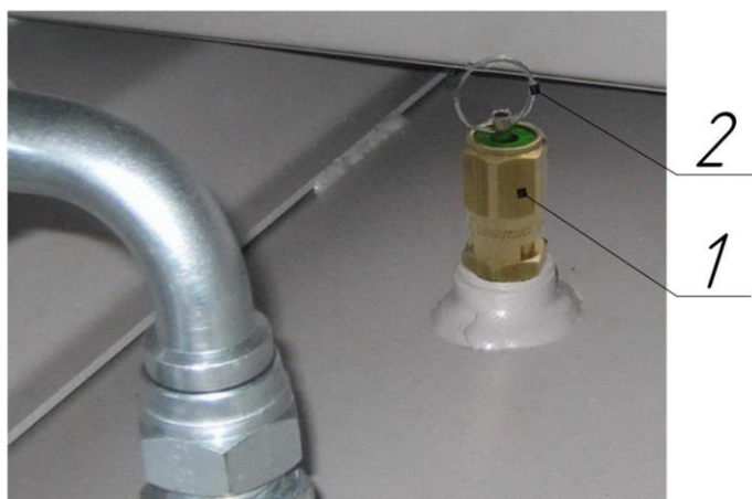
Рисунок 9 – Клапан предохранительный пружинного типа
